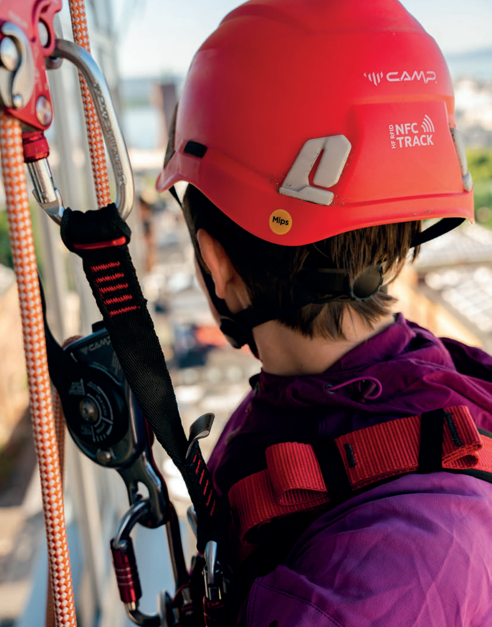
Philippa Betts effettua lavori di manutenzione in accesso su corda sulla facciata di un palazzo. Philippa Betts réalise des travaux d'entretien d'accès sur corde en façade d'immeuble. Philippa Betts bei seilunterstützten Wartungsarbeiten an einer Gebäudefassade. Universitetsgata 2, Oslo, Norway (courtesy of Varri AS, ph.Kyrre Buxrud).
