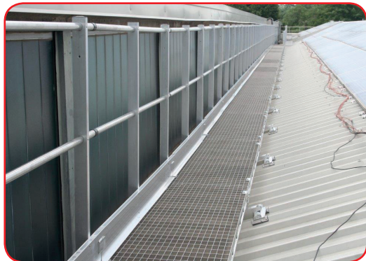
Passerelle montate per ispezione pannelli fotovoltaici
