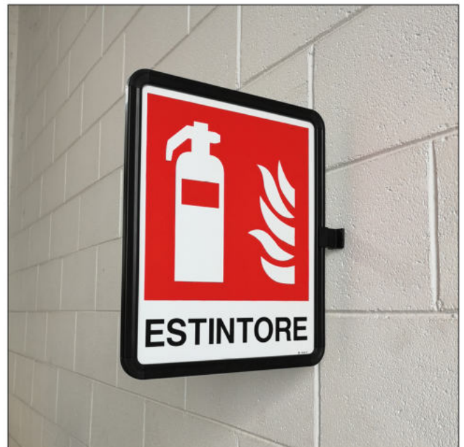
INSTALLAZIONE DI SEGNALI BIFACCIALI
