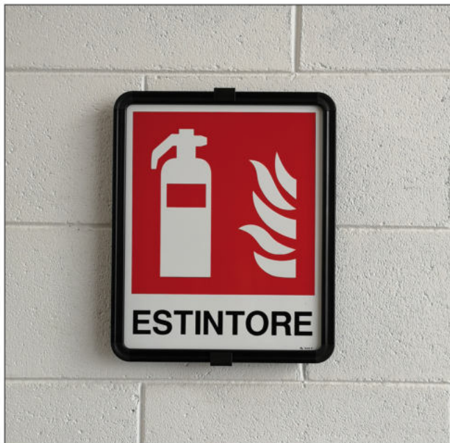
INSTALLAZIONE DI SEGNALI MONOFACCIALI
