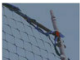
dettaglio anello di aggancio installato
